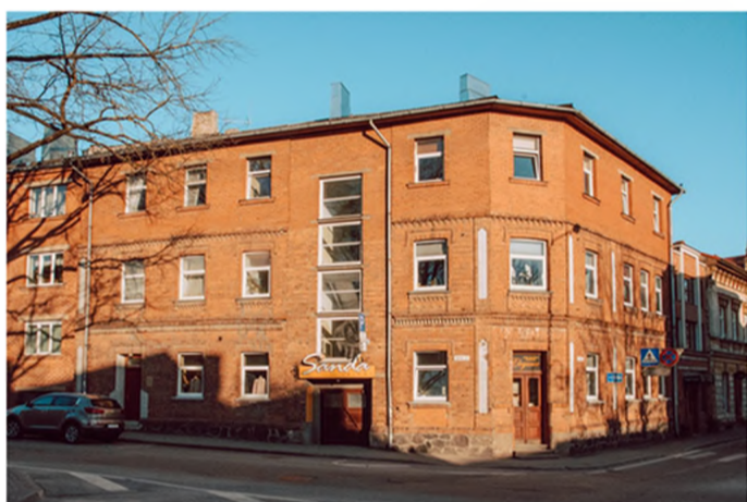
Ēka Valņu ielā 9/11 2019. gadā
